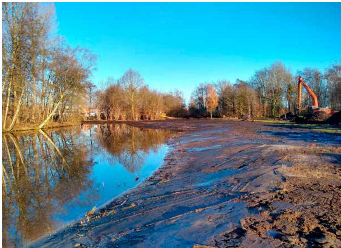
Foto: Aanleg natuurvriendelijke oevers
