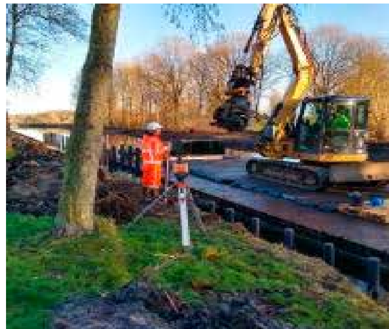
Foto: Aanbrengen van de beschoeiing bij het Winterpad
